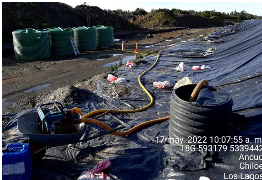
Fotografía N°5: Extracción de Lixiviados desde C12 por personal municipal. Tomada: Martes 17 de Mayo del 2022.
